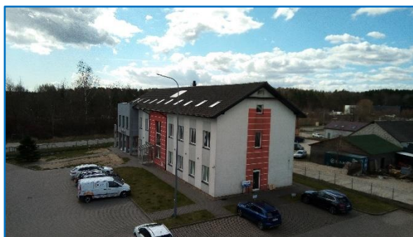
Rys. Widok wschodniej połaci Obiektu budowlanego P.
