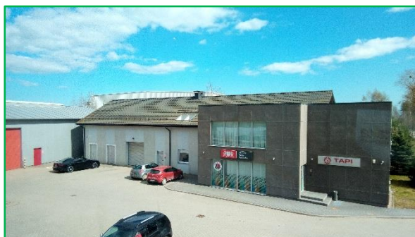
Rys. Widok zachodniej połaci Obiektu budowlanego P.
