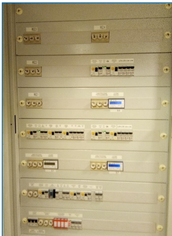
Rys. Obiekt biurowy L wyposażony jest w 2 niezależne rozdzielnice poziome, zabezpieczające obwody elektryczne na poziomie kondygnacji T1 (lewa) i T2 (prawa). W obrębie rozdzielnic T1 i T2 nie istnieje możliwość zlokalizowania falowników sieciowych instalacji fotowoltaicznej ze względu na brak możliwości zagwarantowania przydatności eksploatacyjnej.
