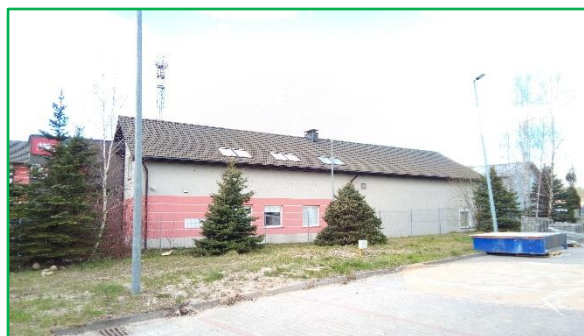
Rys. Widok wschodniej połaci Obiektu budowlanego P.
