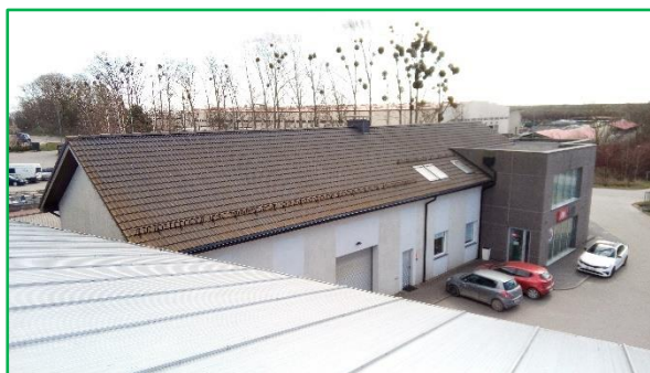
Rys. Widok zachodniej połaci Obiektu budowlanego P.
