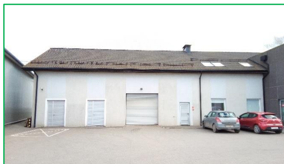
Rys. Widok zachodniej połaci Obiektu budowlanego P.
